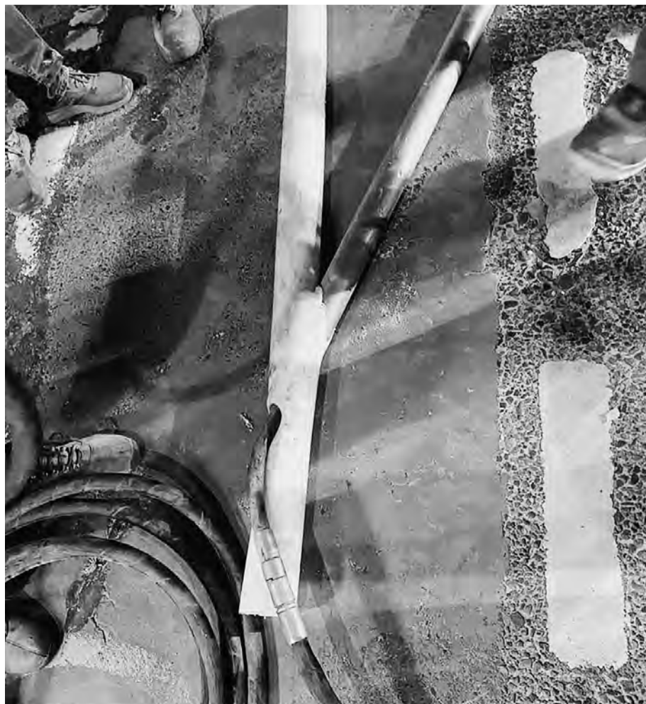
Vor dem Einsatz von Erdraketen sind laut infrest Leitungsausgänge einzuholen.
