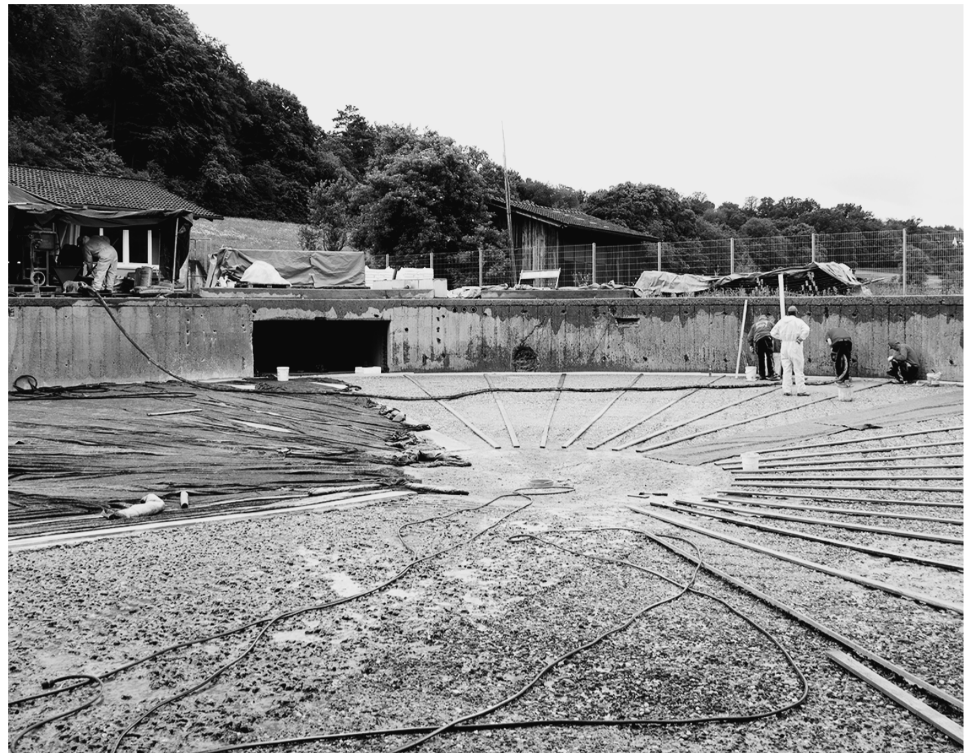
Modernisierungsarbeiten an einem Regenüberlaufbecken. FOTOS: BSN
