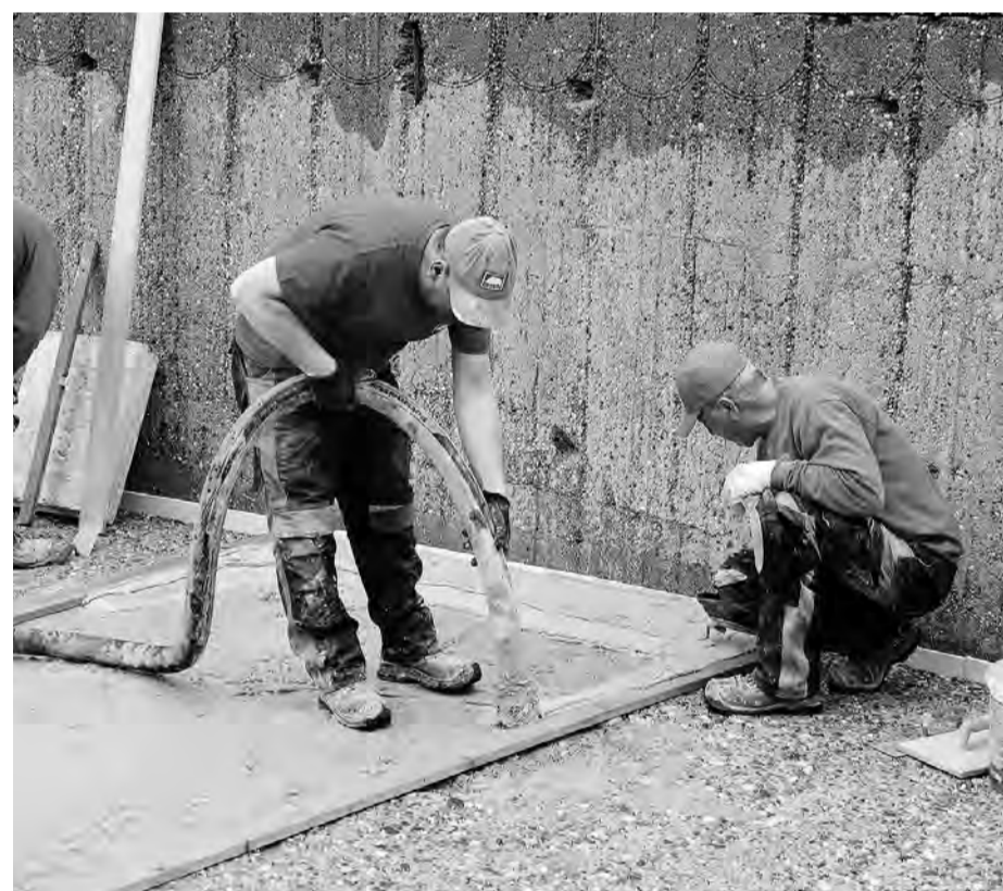
Die Mitarbeitenden arbeiten an der Betonsanierung des Überlaufbeckens.
