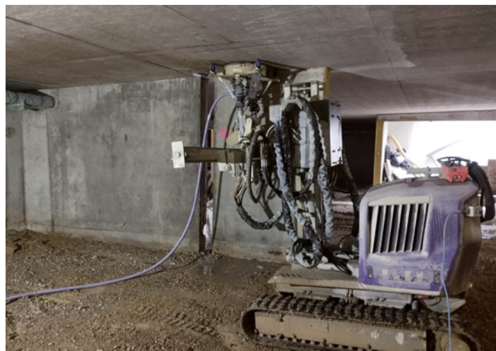
Parkhausdecke: Abtrag und Neubeschichtung präzise umgesetzt – unterstützt durch transparente Kalkulation mit MWM-Pisa. | Foto: BSN GmbH + Co.KG, Mössingen
