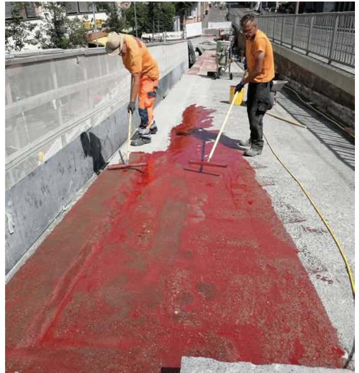
Versiegelung der Stadtbahnbrücke Freiburg
